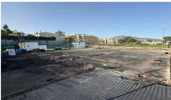
Vista desde el acceso actual
